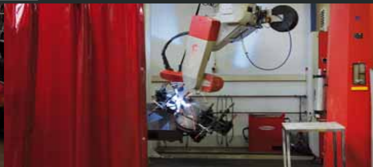
CNC-Schweißen CNC welding
